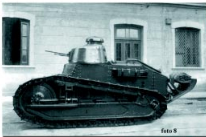
Foto 8 - Renault FT 17 com torre fundida Berliet, armado com metralhadora Hotchkiss calibre 7mm após ter sido reformado nas Oficinas Ferroviárias do Engenho de Dentro, no Rio de Janeiro, em 1932. Esta reforma foi feita às pressas devido a deflagração por São Paulo da Revolução Constitucionalista ocorrida em 09 de julho daquele ano. Foto: Eduardo Coelho
